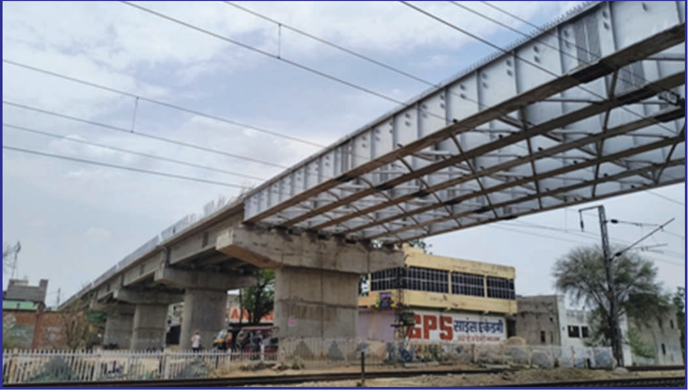
कम्पोजिट गर्डर स्पान 36 मीटर (6 मीटर लीफ) LC 179xROB-11 11 कोटा मथुरा सेक्शन पर परियोजना
