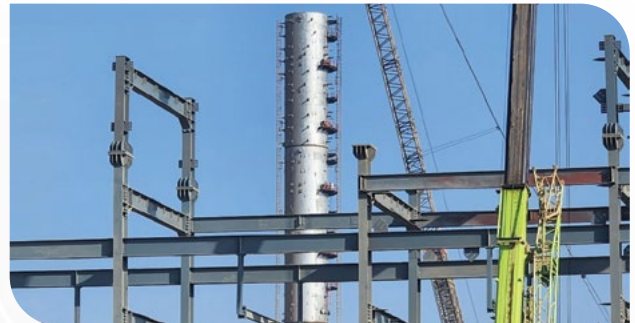
1600 मीट्रिक टन वजन वाला प्रोडक्ट स्लिल्टर कॉलम
