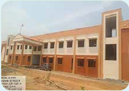
तंगरपल्ली (ओडिशा) स्कूल भवन
