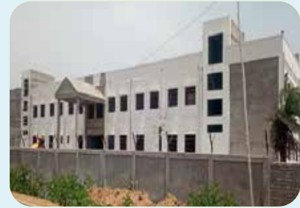
मसलिया (झारखंड) स्कूल भवन
