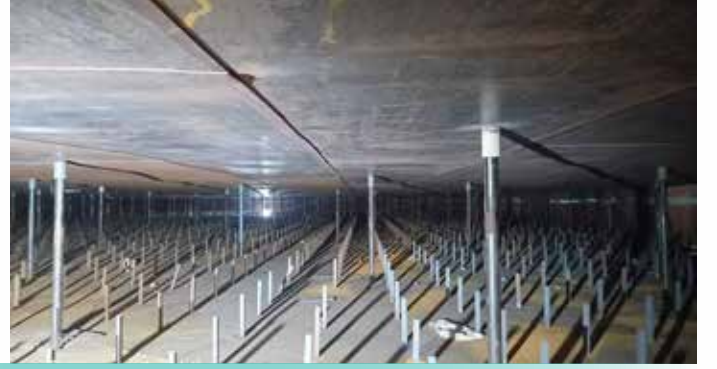
निर्माण के दौरान पानी का उपयोग करने के स्थान पर जैकिंग विधि द्वारा फ्लोटिंग रूफ टैंक की डबल डेक रूफ को उठाना।
