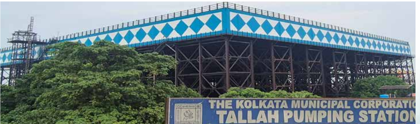
कोलकाता नगर निगम (केएमसी) के लिए अमृत के तहत 9.0 एमजी क्षमता वाले सौ साल पुराने ओवरहेड बैलेंसिंग स्टील जलाशय (तल्लाह टैंक) का नवीनीकरण
