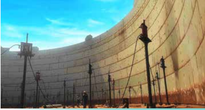
निर्माण के दौरान पानी का उपयोग करने के स्थान पर जैकिंग विधि द्वारा फ्लोटिंग रूफ टैंक की डबल डेक रूफ को उठाना।
