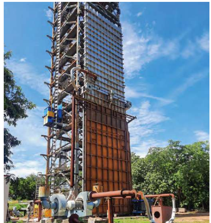
बीएचईएल रानीपेट में गिलोटिन गेट और डैम्पर के परीक्षण के लिए स्थापित 50 मीटर ऊंचा रेटिंग स्टैंड
