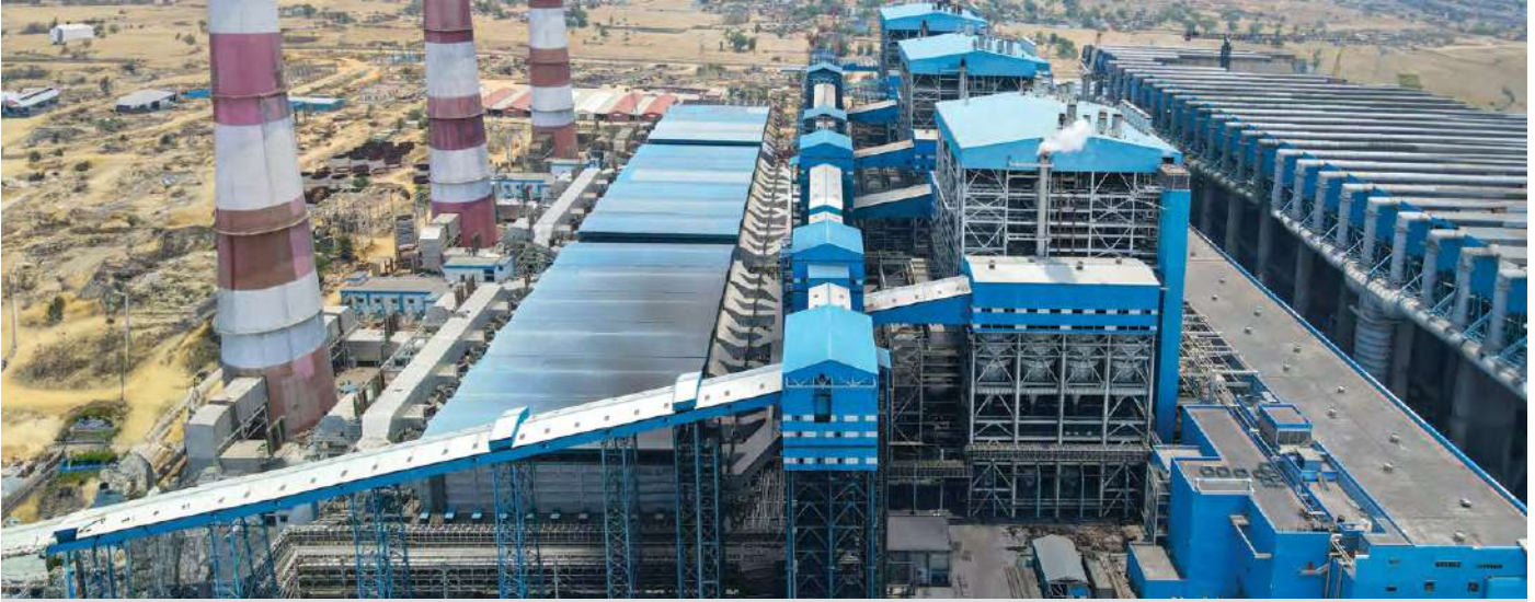
बीएचईएल ने एनटीपीसी नॉर्थ करनपुरा सुपर थर्मल पावर प्रोजेक्ट यूनिट-2 (3x660 मेगावाट) में एयर कूल्ड कंडेंसर (एसीसी) से सुसज्जित देश का पहला यूटिलिटी-स्केल थर्मल पावर प्लांट कमीशन किया।
