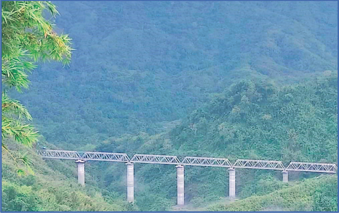
बैराबी - सैरांग, मिजोरम के बीच रेलवे ब्रिज नंबर 78 Railway Bridge no.78 between Bairabi - Sairang, Mizoram
