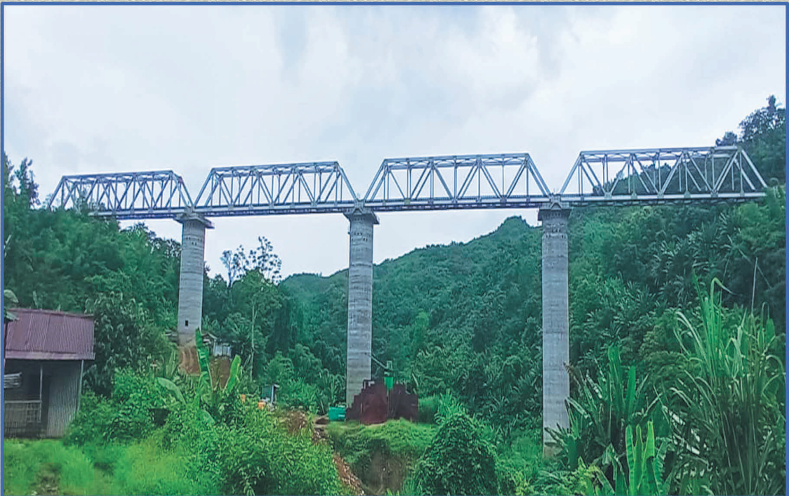
बैराबी - सैरांग, मिजोरम के बीच रेलवे ब्रिज नंबर 15 Railway Bridge no.15 between Bairabi - Sairang, Mizoram
