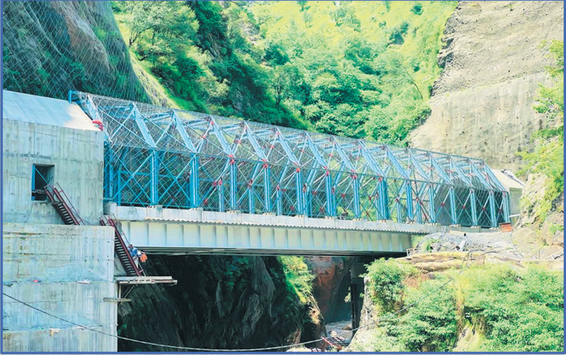
जम्मू और कश्मीर में रामबन जिले में, संगलदान खंड पर यूएसबीआरएल परियोजना के तहत, ब्रिज नंबर 1 Bridge no.1 at Jammu & Kashmir in district Ramban, under the USBRL project at Sangaldan section
