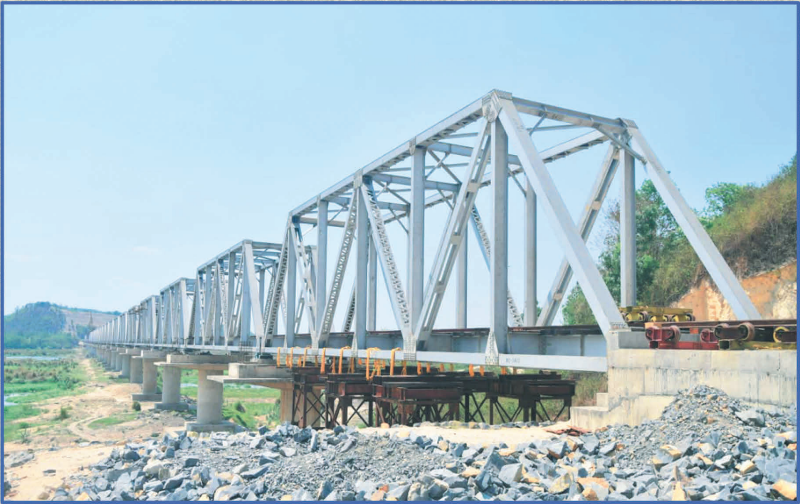
रेलवे ब्रिज नंबर 3, हसदेव, छत्तीसगढ़ Railway Bridge no.3, Hasdeo, Chhattisgarh
