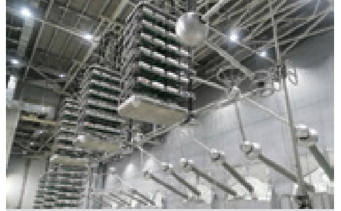
बीएचईएल द्वारा पश्चिमी क्षेत्र गिड (रायगढ़, छत्तीसगढ़) और दक्षिणी क्षेत्र गिड (पुगलूर, तमिलनाडु) के बीच सफलतापूर्वक क्रियान्वित 800 kV, 6,000 डै अल्ट्रा हाई वोल्टेज डायरेक्ट करंट (यूएचवीडीसी) लिंक का डीसी हॉल
