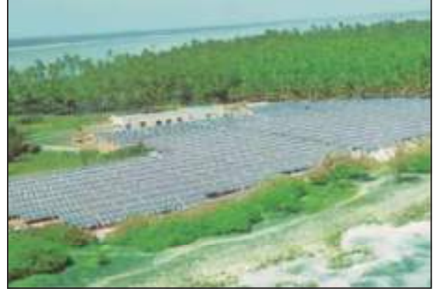
भेल द्वारा लक्षद्वीप में चालू किया गया 760 केडब्ल्यूपी क्षमता का देश का सबसे बड़ा डीजल ग्रिड-इंटरैक्टिव सौर ऊर्जा संयंत्र
