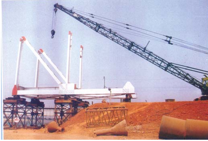
कटक में ब्रेथवेट बर्न एण्ड जेसप कंस्ट्रक्शन कं. लि. द्वारा महानदी के ऊपर पुल का निर्माण
