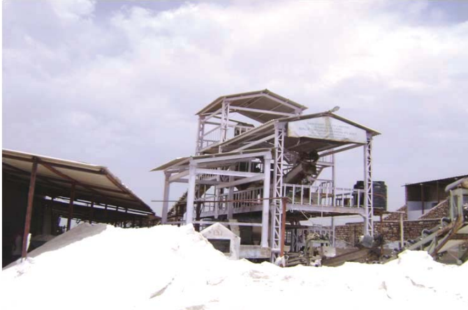
एचएसएल - सांभर झील, राजस्थान में साल्ट अपग्रेडेशन प्लांट
