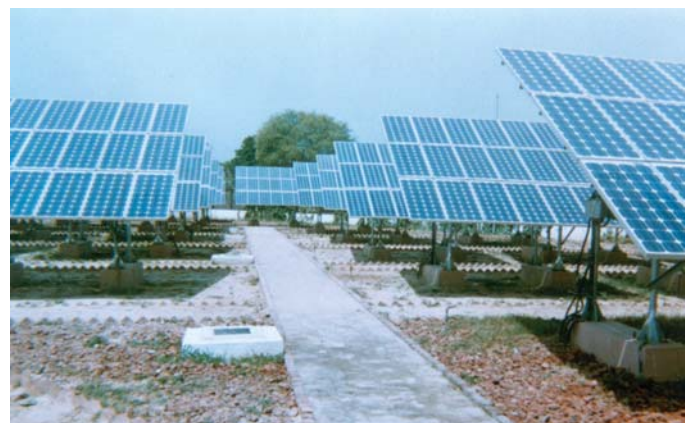
आरईआईएल द्वारा विनिर्मित बुस्टिंग गिड टेल-इंड के लिए एसपीवी गिड इंटरएक्टिव पावर प्लांट (50 कंडब्ल्यूपी)
