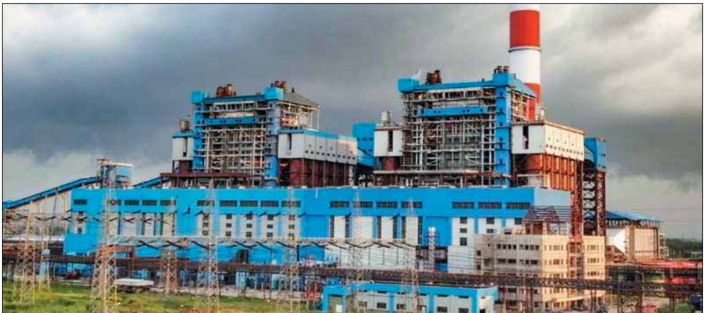
पश्चिम बंगाल के अंडाल में डीवीसी के दुर्गापुर स्टील थर्मल पावर स्टेशन में 2x500 मेगावाट यूनिट सं. 1 और 2 के लिए पावर ब्लॉक यूनिट
