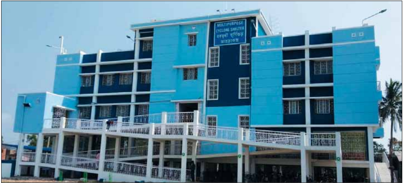
पश्चिम बंगाल सरकार के आपदा प्रबंधन विभाग के लिए राष्ट्रीय चक्रवात जोखिम उपशमन परियोजना के तहत 98 बहुउद्देशीय चक्रवात आश्रयों का निर्माण।
