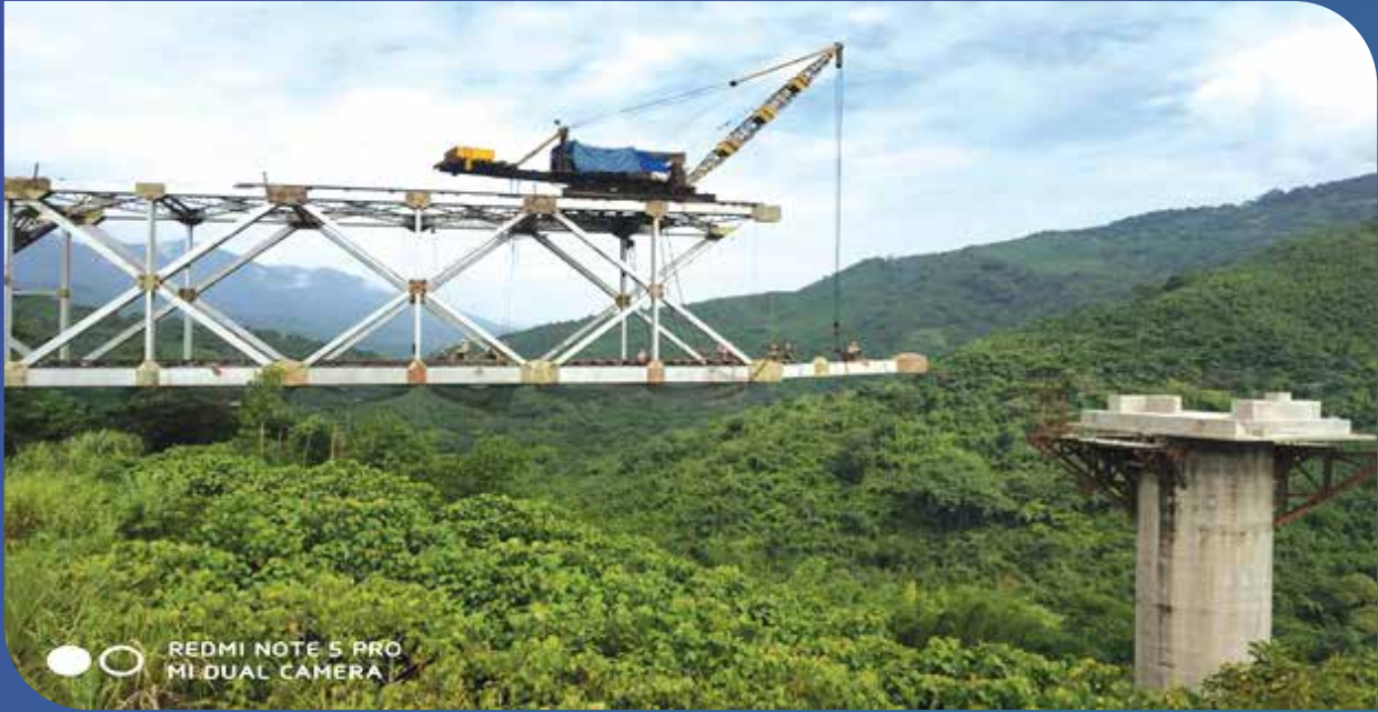
Erection is in progress for Bridge No.130 at Khungsung, Manipur. खुंगसुंग, मणिपुर में पुल संख्या 130 का निर्माण कार्य प्रगति पर है।
