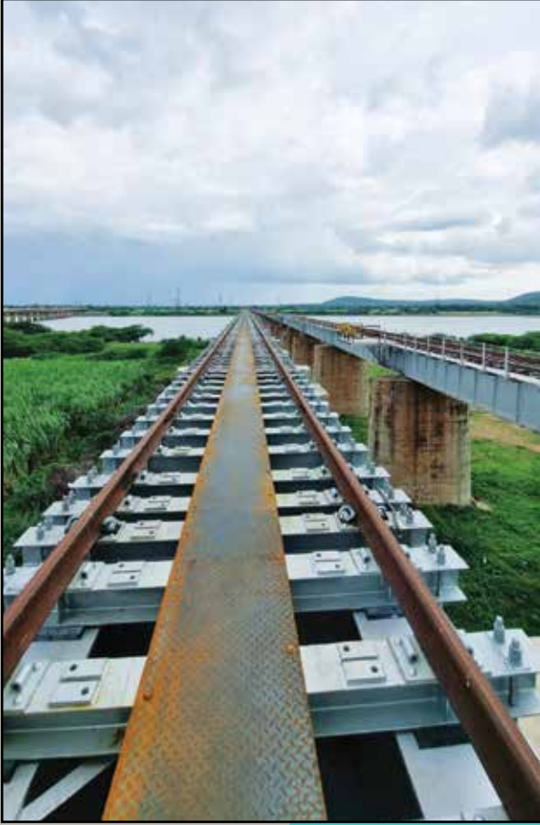
Erection is in progress for Bridge at Gadag Hodgi, Karnataka गडग-होटगी,कर्नाटक में पुल का निर्माण कार्य प्रगति पर है
