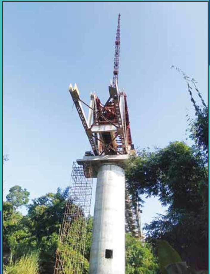
बैराबी, मिजोरम में पुल निर्माण कार्य प्रगति पर है - Erection is in progress for Bridge at Bairabi, Mizoram
