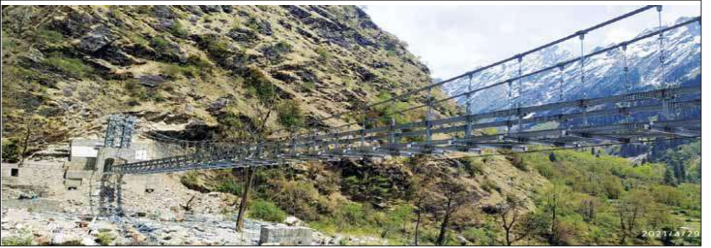
पीडब्ल्यूडी, उत्तराखंड के लिए चमोली जिले में 10 केएम पर गोविंदघाट से घांघरिया रोड पर 135 मीटर लंबा सस्पेंशन पैदल यात्री लोहे का पुल।
