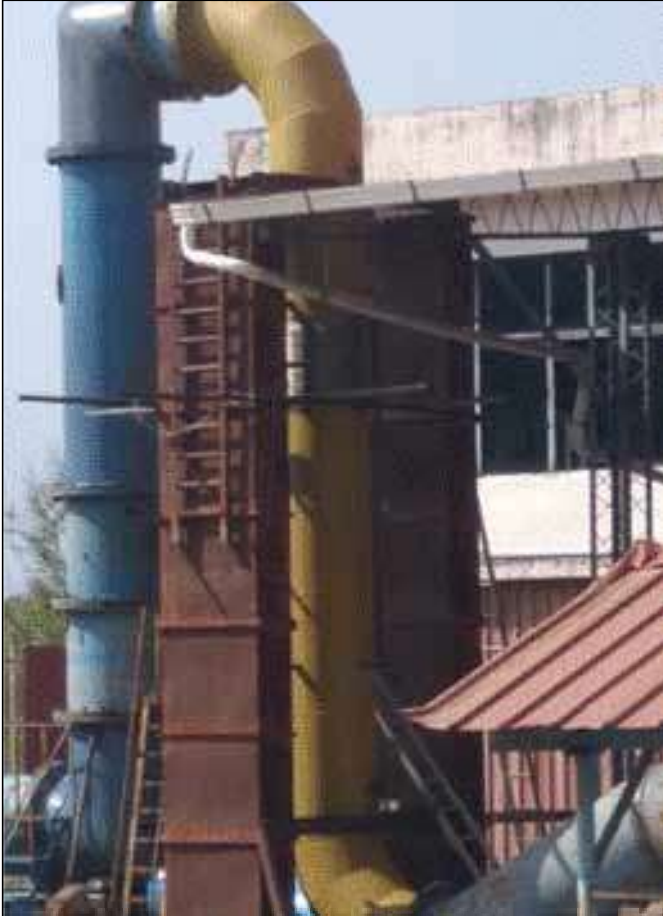
800 एनबी आकार की बेलो असेंबली का परीक्षण
