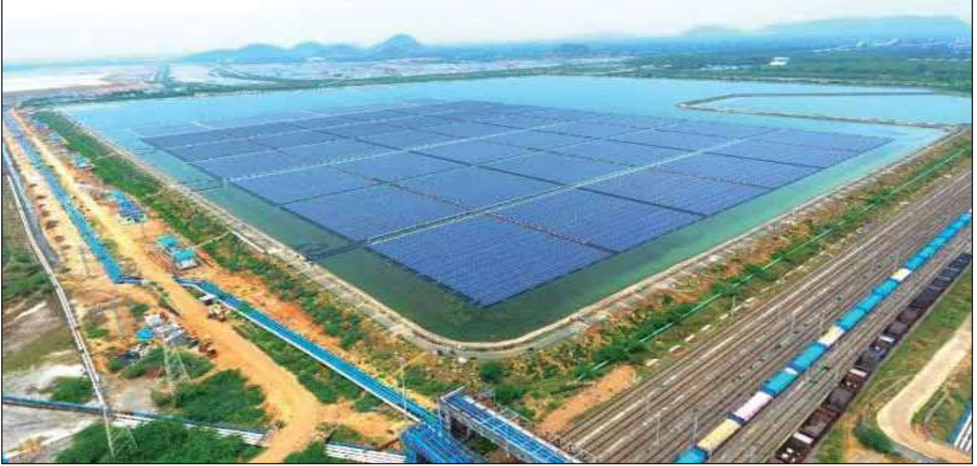
भेल द्वारा संचालित किया गया भारत का सबसे बड़ा 25 मेगावाट एनटीपीसी सिम्हाद्री फ्लोटिंग सोलर पीवी संयंत्र
